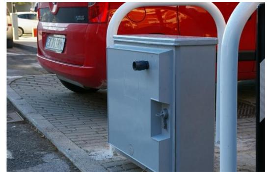
**DMV08\_CL5** viene installato a bordo strada, non devono essere effettuati lavori sul manto stradale ed è completamente autonomo dal punto di vista energetico in quanto alimentato da pannelli solari.
